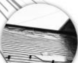
強風による 屋根の剥がれ
