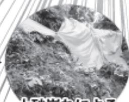
土砂崩れによる 家屋の破損
